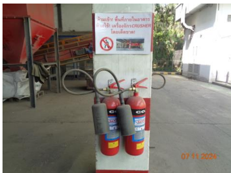
ภาพที่ 2.2-32 ถังดับเพลิงชนิด CO 2 บริเวณ Crusher plant
